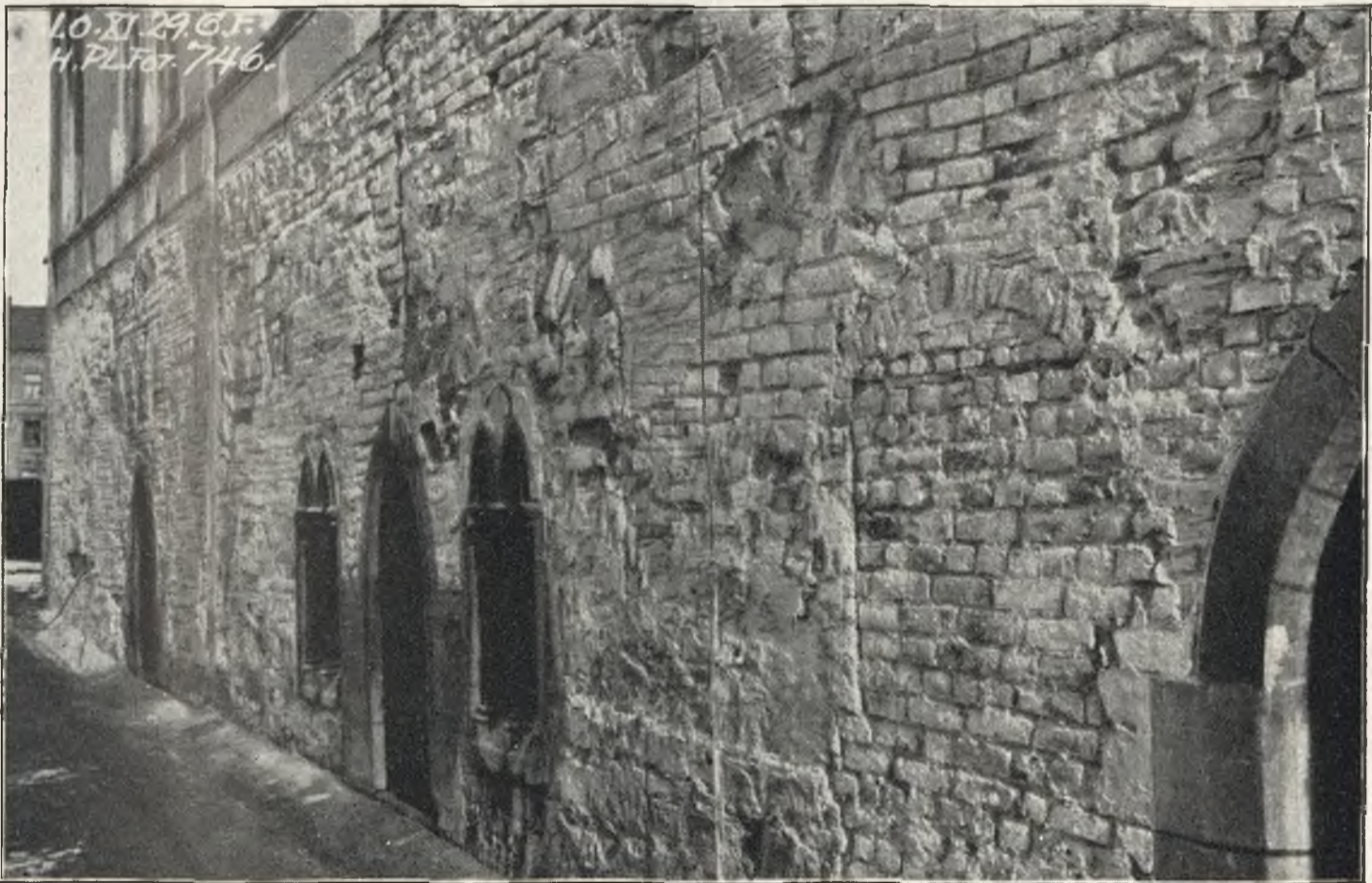
Abb. 10. Vom ehemaligen Dominikanerkloster in Oslo. Westwand der jetzigen Bischofswohnung mit Spuren der Gewölbe im ehemaligen Kreuzgang
