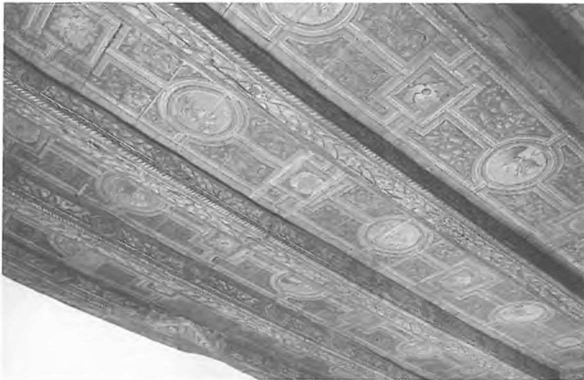
Abb. 10: Holzbalkendecke im Wohnhaus Heinrich Töbings, Schröderstr. 16. Letztes Viertel 16. Jh. (Institut für Bau- u. Kunstgeschichte Hannover, Baugutachten, Prof. Dr. Cord Meckseper)
